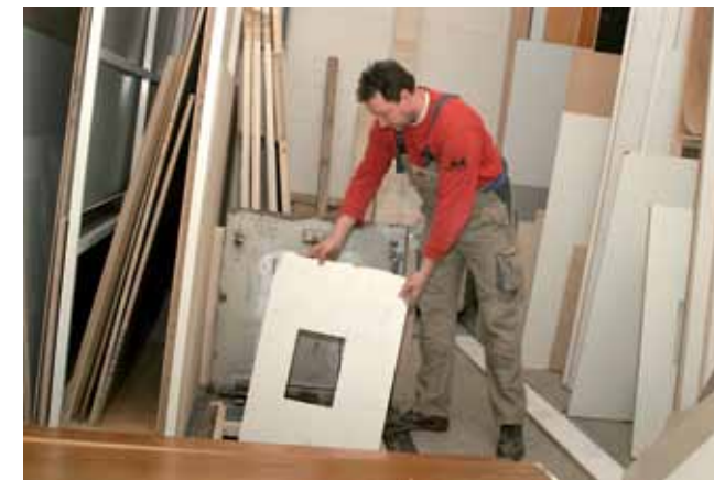
Neues Futter für die Heizung: Durch eine Klappe im Boden füllt Frank Schneider den Häcksler, der die Holzreste zu handlichen Hack-schnitzeln zerkleinert.
